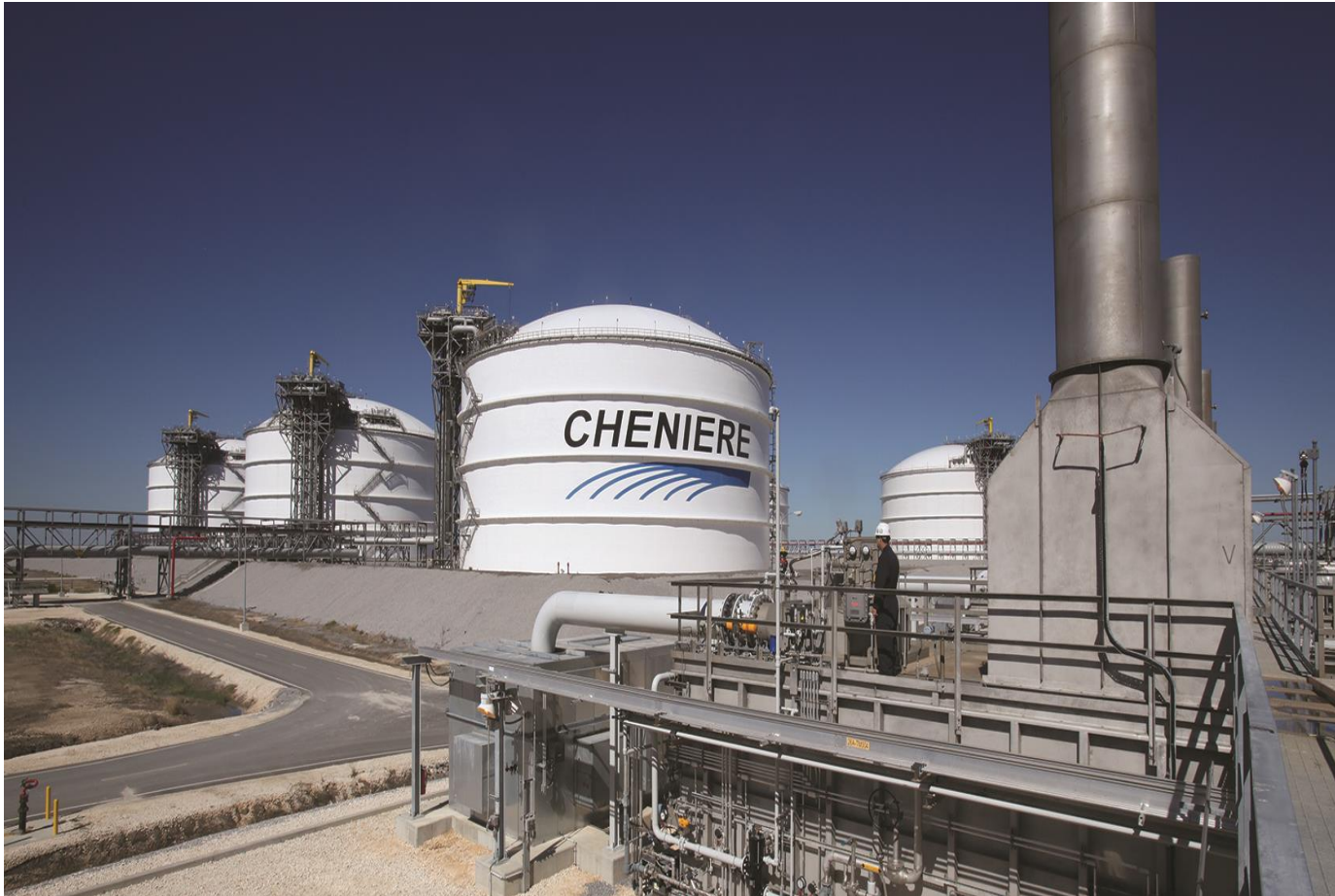
Sabine Pass LNG – Courtesy Cheniere Energy
