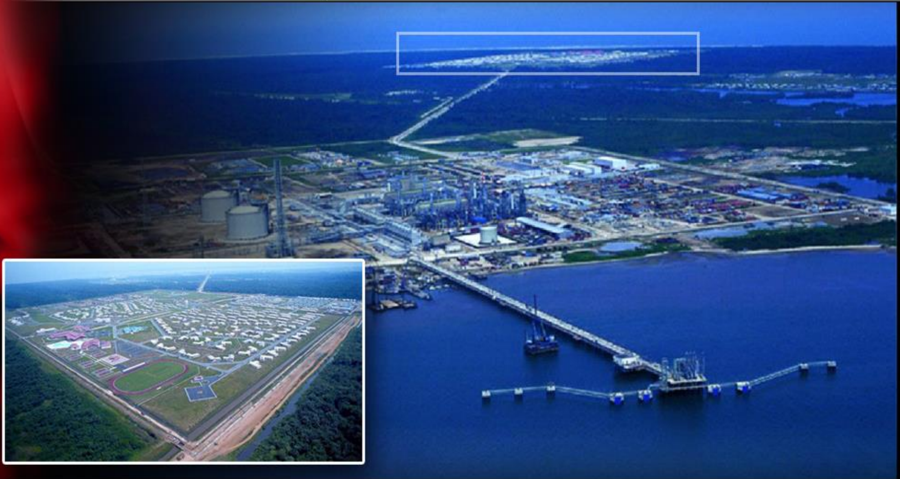
NIGERIA LNG FACILITY
